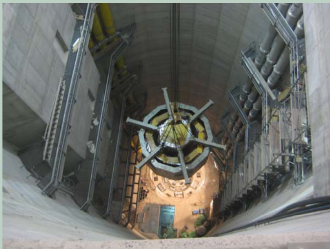
Spust statorja 8. april 2009
