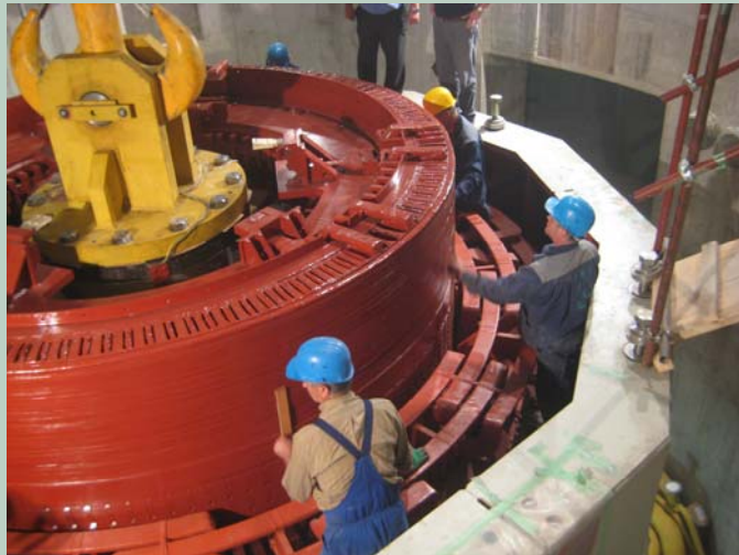
Spust rotorja v stator
