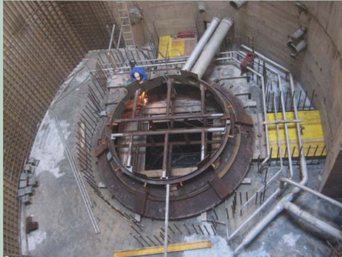
Obloga turbinskega jaška in vgradne cevi
