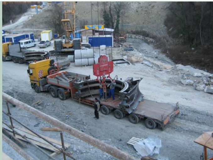
1 / 2 obroča spiralnega ohišja s predvodilnikom
