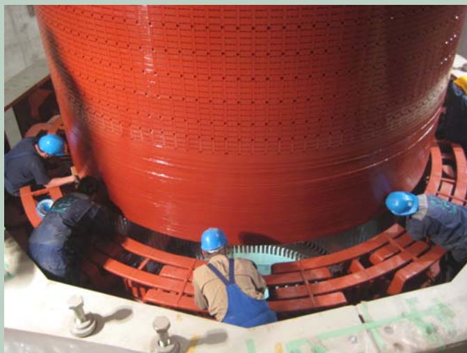
Spust rotorja v stator
