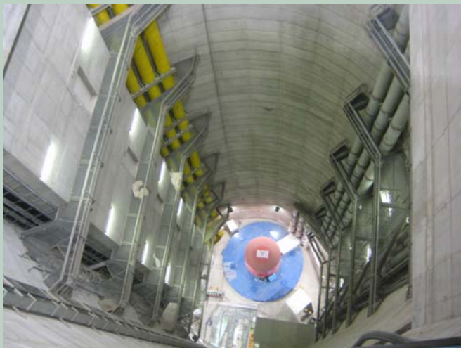
STROJNIČNI JAŠEK 14.september 2009
